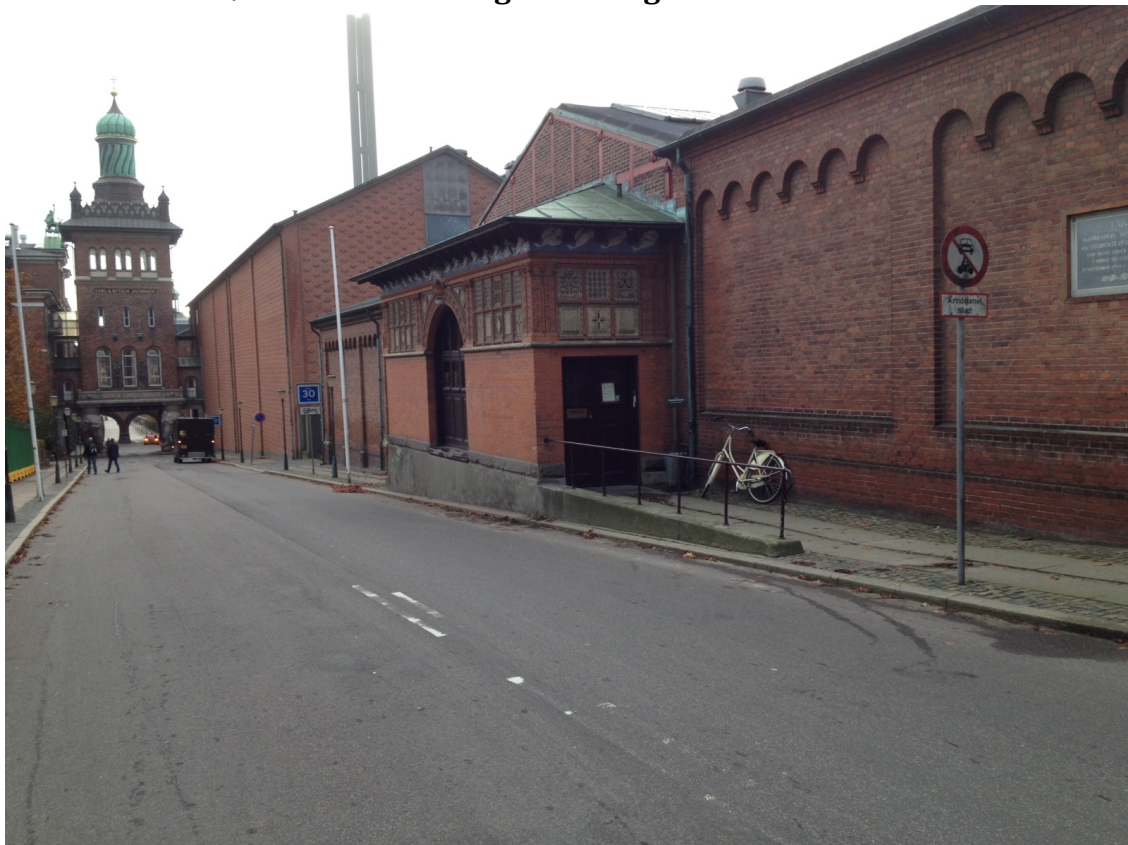
Indgang til Carlsberg Museum & Business Center er døren til højre på billedet.
